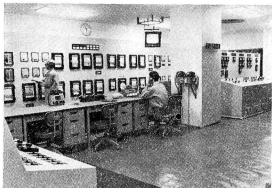
写真一四 藻岩第2浄水場 管理室
