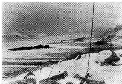
写真—2 40 年 1 月 9 日被災状況
