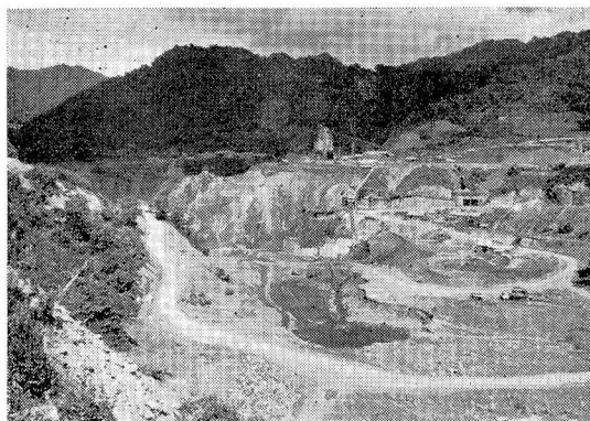
写真—4 主要仮設備全影
