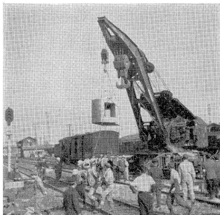
写真—8 クレーンによる函渠敷設
