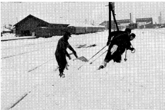
写真—2 雪馬による除雪作業
