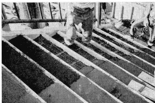
写真-8 稲穂学校と線橋階段部融雪装置 ニクロム線を配列しているところ。 取付後アスファルトモルタル厚 30 mm を施工する。
