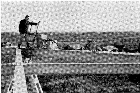
写真-2 岩見沢大橋応力測定
