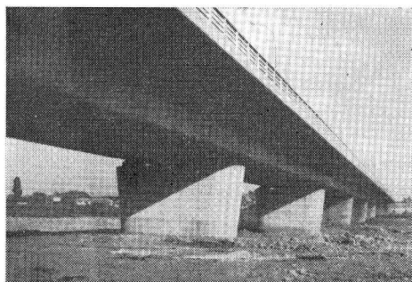
写真—1 南大橋全景
