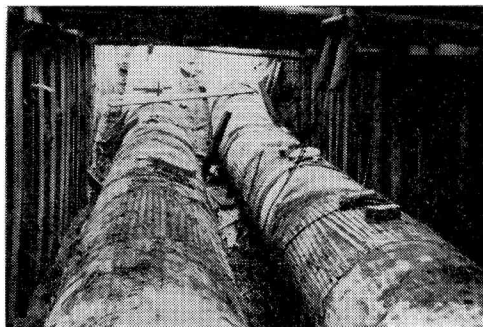
写真-1 鋼管敷設状況
