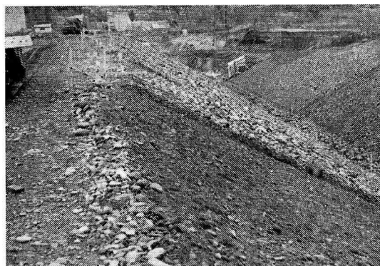
写-3 基盤整正完了
