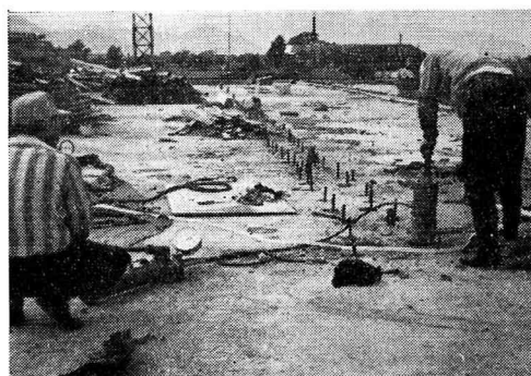
写真一〇 鉛直方向 PC 鋼棒
