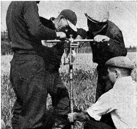
写真-2 二重管式コーンペネトロメーター
