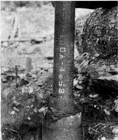
写真-2 ストレーナー・パイプ挿入状況
