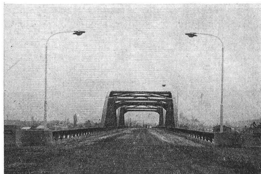
写真—1 完 成 写 真
