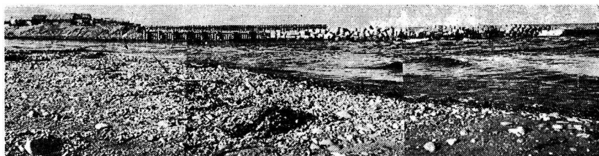
写真-1 試験工事竣工状況
