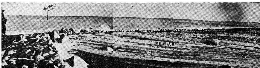
写真-2 河口閉塞および防砂突堤の崩壊流出状況
