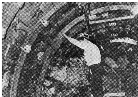
写真-3 可縮枠の冠材と側材の組み立て
