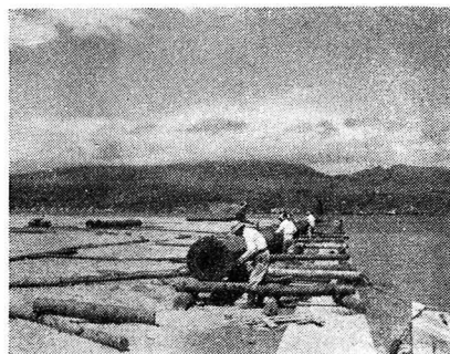
写真-2 海底管の陸上組立て
