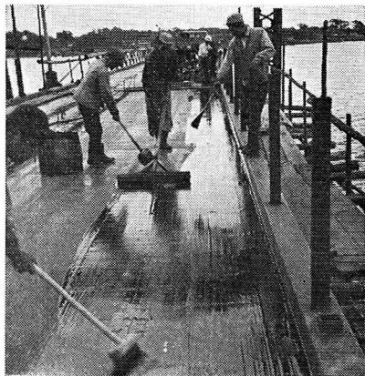
写真-6 Tar rubber latex の塗布
