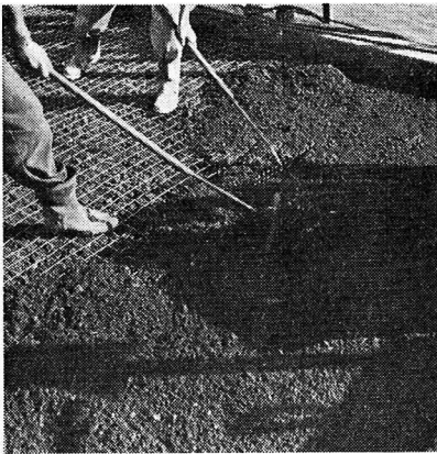
写真—9 上層 Topeka asphalt concrete 舗設
