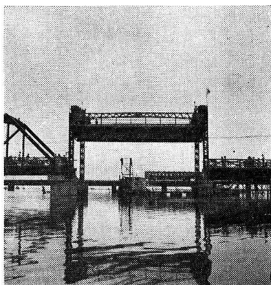
写真-1 改造部ガーダーが最高に昇つた状態
