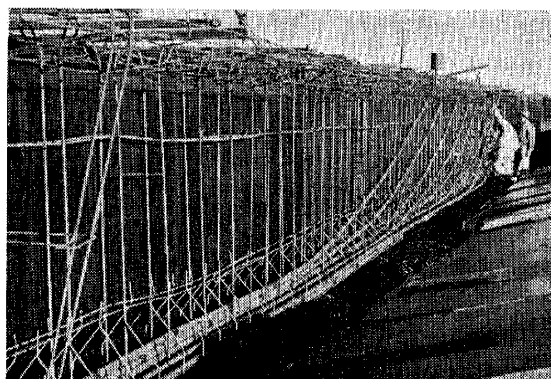
写真-3 鉄筋，シースの組立状況
