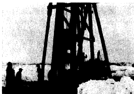
写真—1 打込試験 (昭和28年3月2日～3日)
