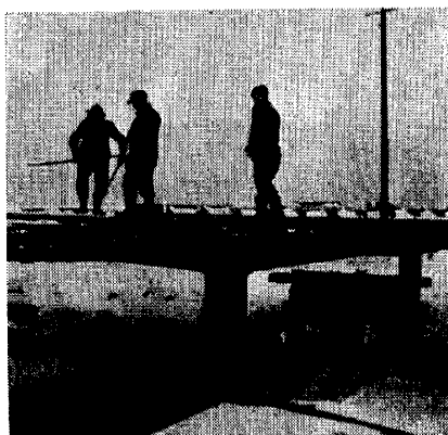
写真—9 30 ton 載荷完了
