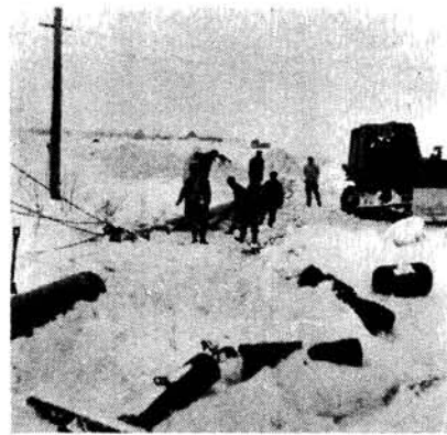
写真-14 杭の牽引 前方右 9 ton ブルトーザー 右手前 接合バンド
