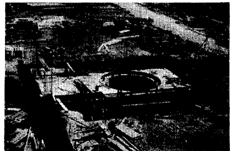
写真-4 R.C 基礎打上り状況
