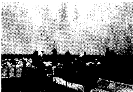
写真—11 水深を測りながら玉石を投入している処
