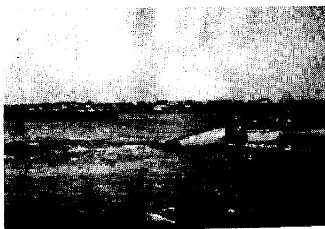
写真—2 昭和27年4月に倒壊せる導流堤状況 この前面に4個の埋没せる函塊あり
