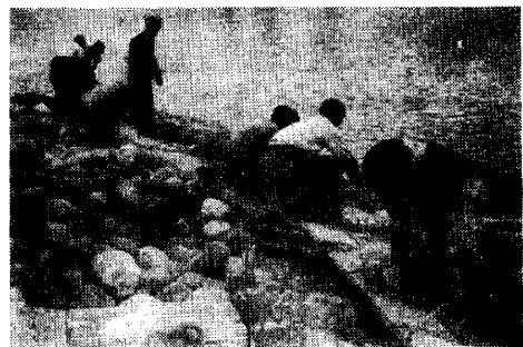
写真-8 函塊基礎の蛇籠投入台の状況並びに詰石作業
