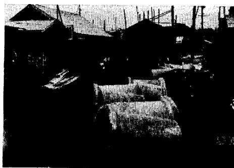
図一8(4) 駅前通りを建物引去り しているところ
