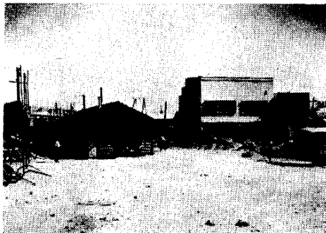
図—9 (2) 工事着手前の駅前広場 (向って左側の木造建物は火災直後建設さ れた岩内仮駅舎、右側のバスが停車して いるところが、在来の駅前の線であるが 中央に見える2階建〔中央バス岩内営業 所〕まで駅前広場が拡張される)
