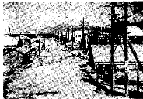
図—11 アスバラの坂上から岩内駅を望む (街路工事着手前)
