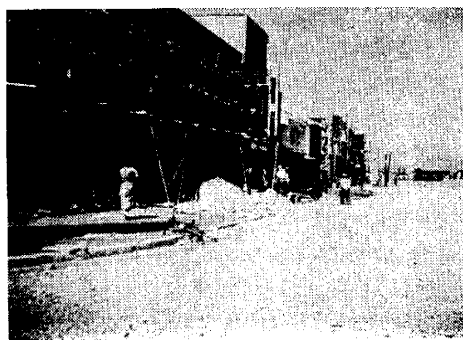
図-6 駅前線の街路工事の一部完成したところ (向つて左端から2番目の建物は 岩内仮駅舎である)
