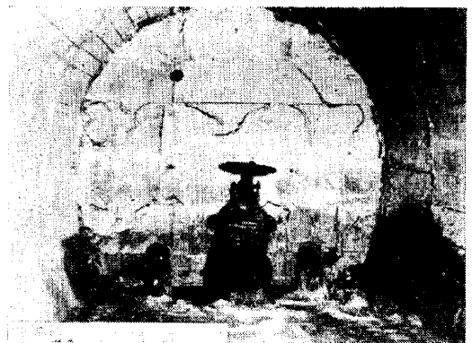
写真—4 一號隧道下口(G坑)側隔壁と壓氣による出水
