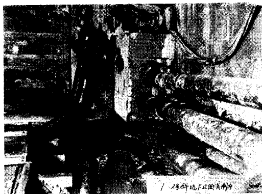
写真—3 二號斜坑副坑側氣閘内部 （パイプ、電らん及び閘扉）
