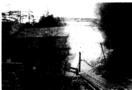
写真—1 第二号斜坑の坑口附近 (坑内から出る湯気の状況)
