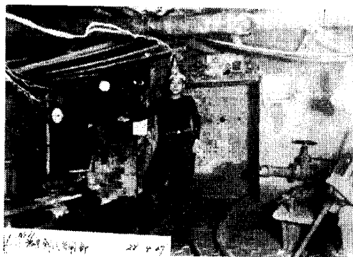
写真—2 二號斜坑主坑側氣閘 （大氣側よりみる）
