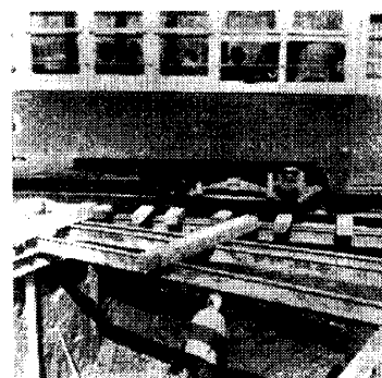
写真-9 覆工材で電車荷重 を受けている所
