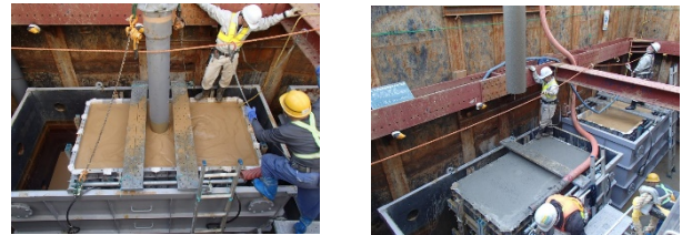
写真-2 現場打設実験の状況
