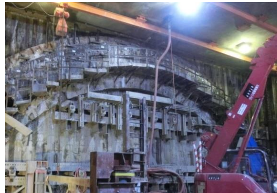
写真-2 角形エレメント上半部推進完了状況
