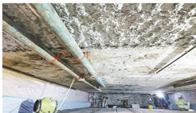
コンクリート配管設置
