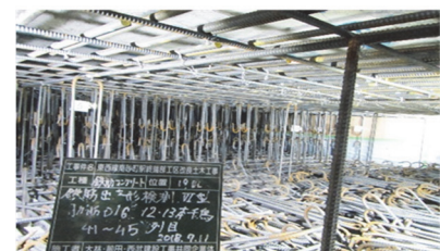
鉄筋組立(肋筋)
