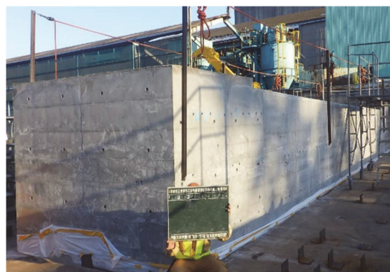
写真-3 高流動無収縮コンクリート出来形
