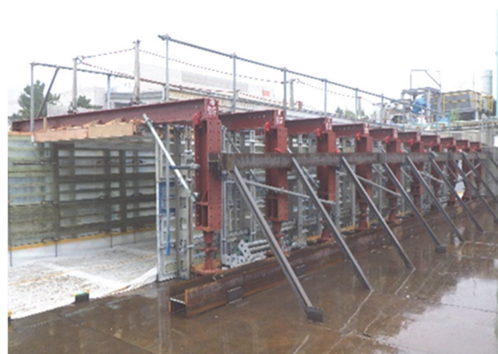
写真-2 試験施工用型枠 (クリアパネル)
