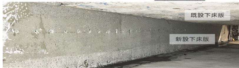
型枠脱型、充填確認
