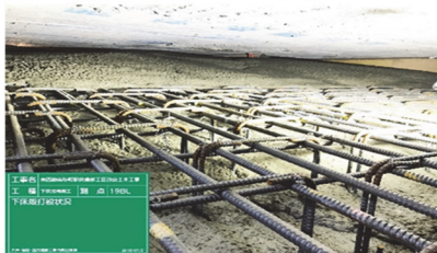
コンクリート打設
