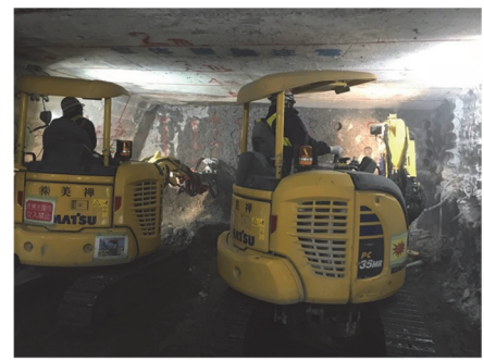
写真4 導坑掘削状況
