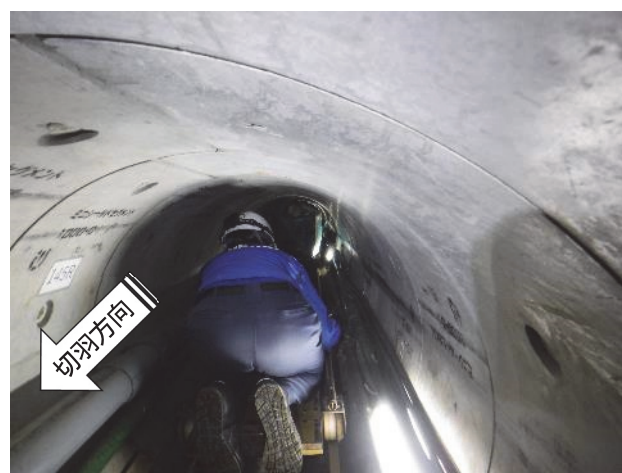
写真3 坑内計測状況
