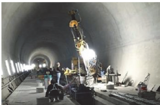
写真1 グラウンドアンカー施工状況（軌道工事前）
