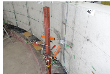
【45°、135°の内空変位測定(直角2方向)】
