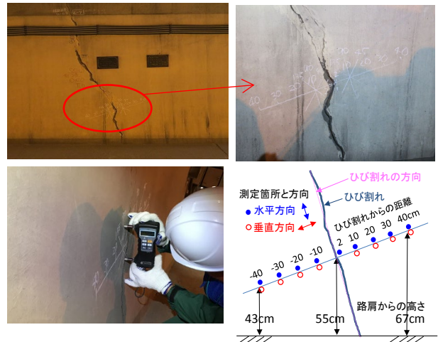
写真2 ひび割れ周辺部の測定箇所と測定状況
