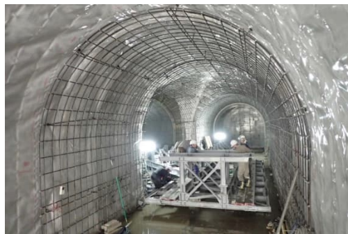
写真6 覆エコンクリート補強鉄筋
