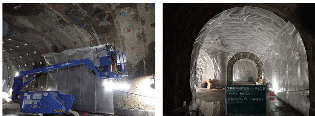
写真4 交差部・屈曲部の湧水対策
