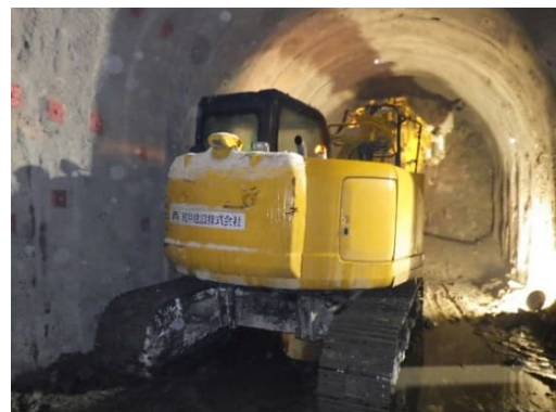
写真-3 交差部での機械掘削
