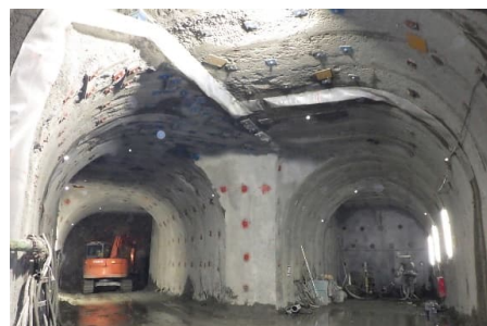
写真-2 交差部施工状況
