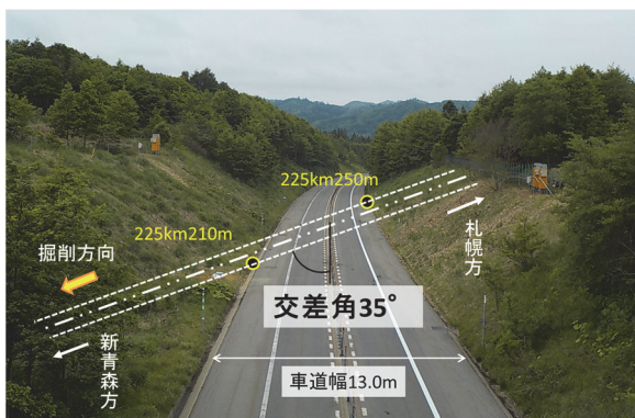
図-4 高速道路交差部の現地状況
