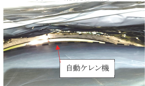
写真-3 自動ケレン機の設置
