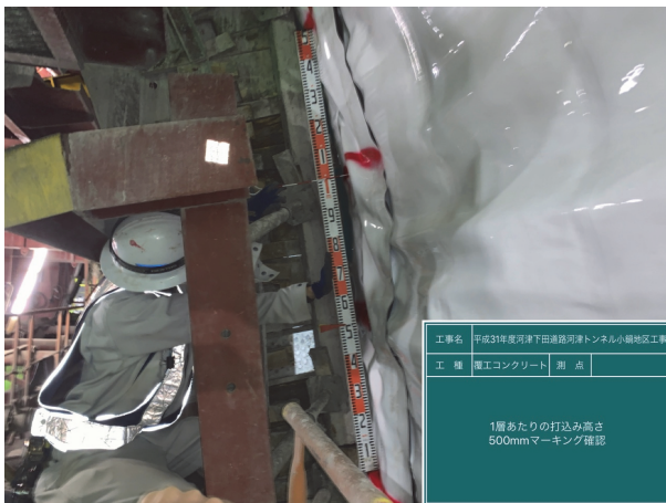
写真-1 防水シート 50cm マーキング
