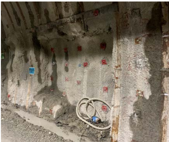
写真-1 箱抜きの施工状況
