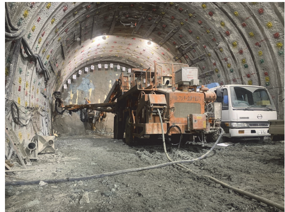
写真-2 新支保パターン (E) 施工状況
