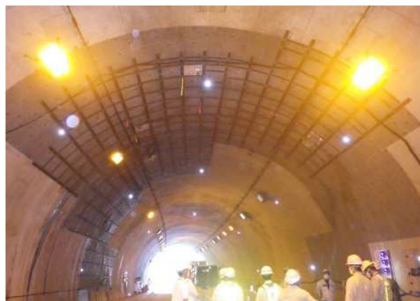
図-6 一次はく落防止措置
