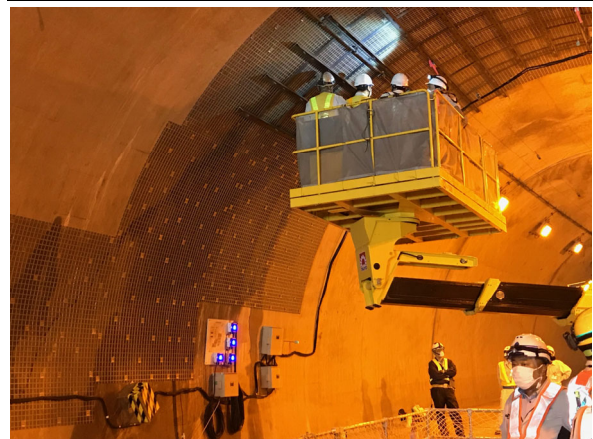
図-10 OSV 機器作動状況(上部作業時)
