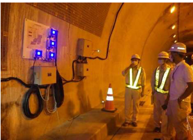
図-9 OSV 機器設置状況
