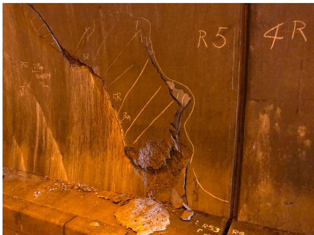
図4 トンネル損傷区間の状況（せん断破壊）
