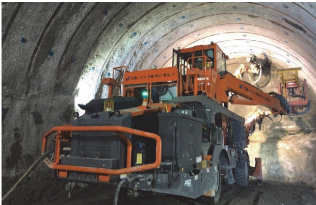
写真-1 全自動ドリルジャンボ (外観)
