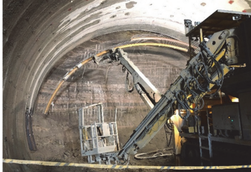
(c) 支保工建て込み並びに計測器設置状況
