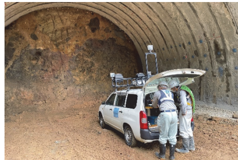
写真-2 切羽写真の取得状況
