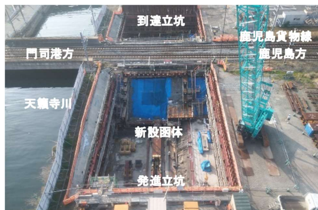
図-2 施工箇所全景
