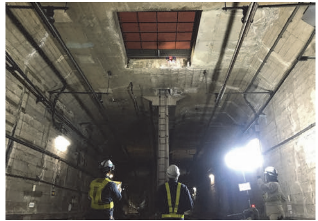
写真8 ドローンによる検査（上床開口部）
