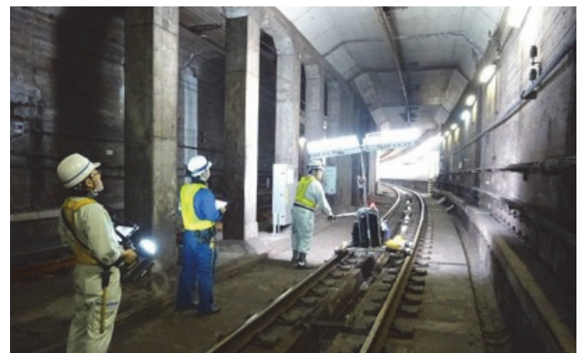
写真-1 トンネル検査
