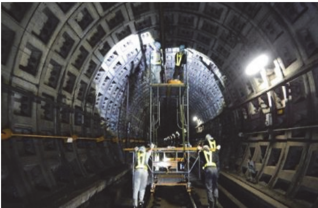
写真-3 足場による確認
