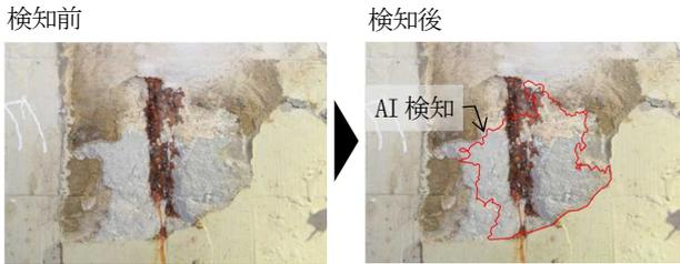
図-20 剥離の検知例 (赤線 AI)
