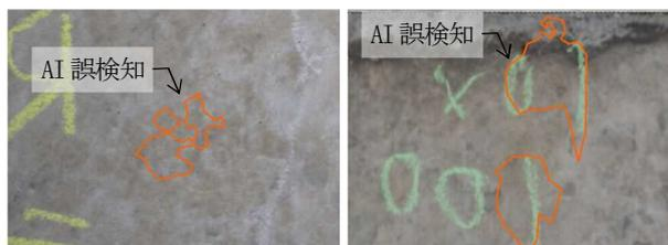
図-19 浮きの誤検知例 (橙線AI)
