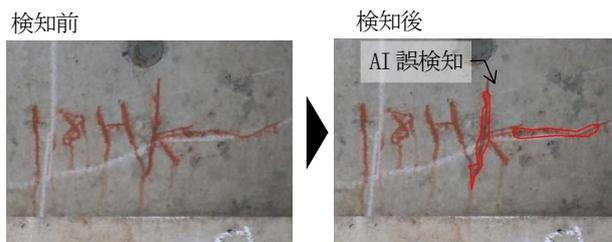
図-16 鉄筋露出の誤検知例 (赤線AI)
