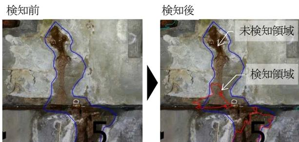
図-12 漏水跡の検知・未検知例 (青線トレース、赤線AI)
