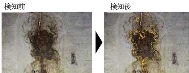
図-11 漏水跡の検知例 (黄線 AI)
