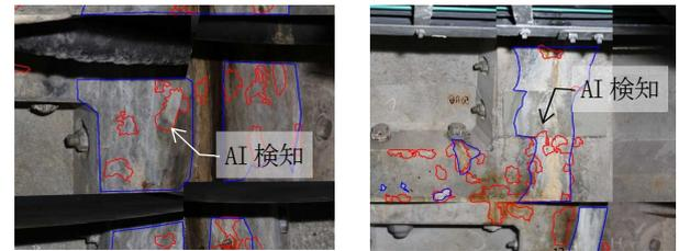
図-25 エフロの検知例 (青線トレース, 赤線 AI)
