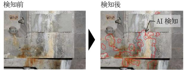
図-24 エフロの検知例 (青線トレース, 赤線 AI)
