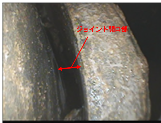
写真-2 中央排水管のジョイント開口部
