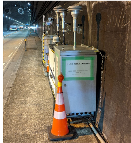
写真-1 実態調査の状況
