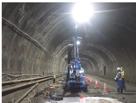
写真3 トンネル内での試験施工状況
