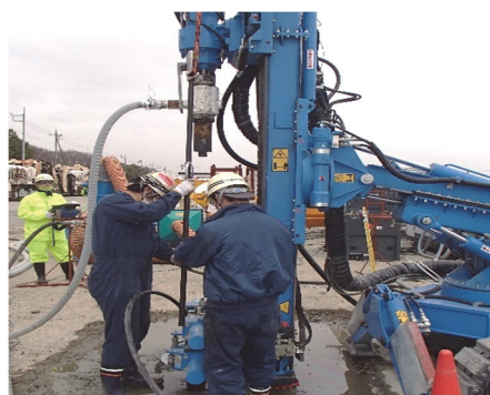
写真4 ロックボルト打設状況
