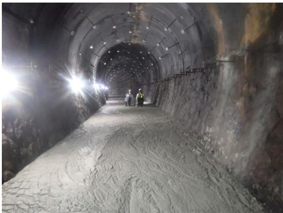
写真-2 トンネル閉塞工 (エアミルク充填状況)<sup>1)</sup>
