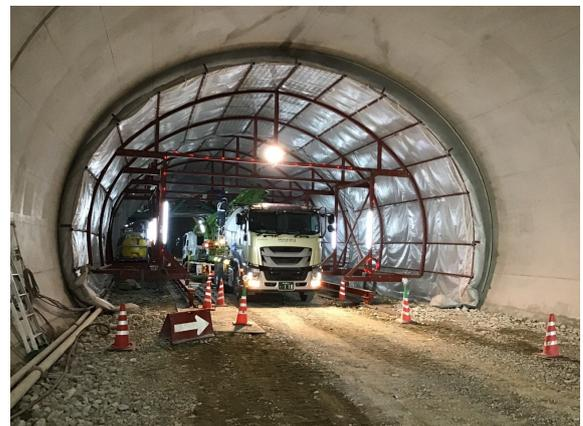
写真-6 覆工コンクリート打設・養生状況
