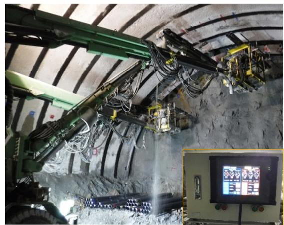
写真-5 切羽前方探査実施状況
