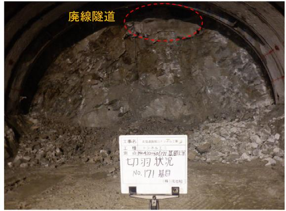
写真-3 旧 JR 隧道出現状況<sup>2)</sup>
