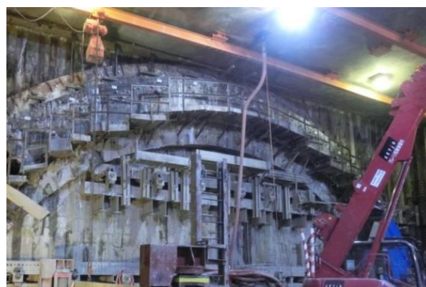
写真-4 角形エレメント上半部推進完了状況
