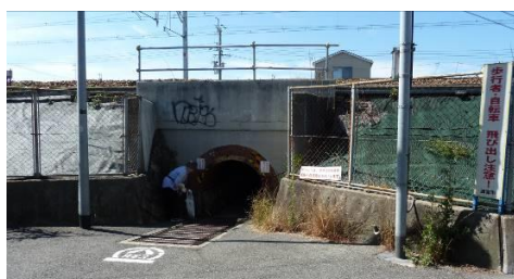
図-1 小断面レンガトンネル
