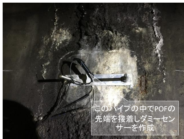
図-19 ダミーセンサーを設置した状況
