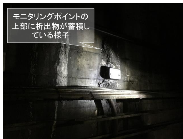
図-20 ダミーセンサーの設置を完了した状態
